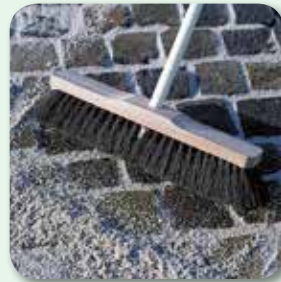
mittels feuchtem Besen abfegen
