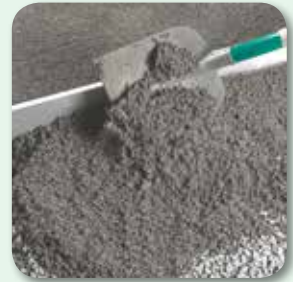
Mörtel aufbringen und über Lehren abziehen
