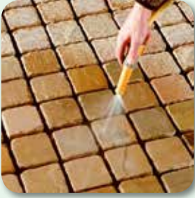
Fläche rückstandsfrei reinigen und vornässen
