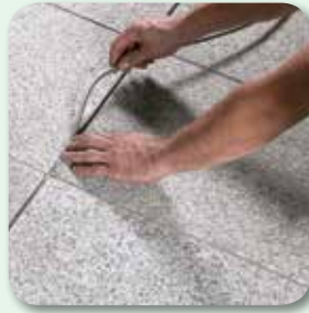
Fugentiefe durch PE-Rundschnur fixieren
