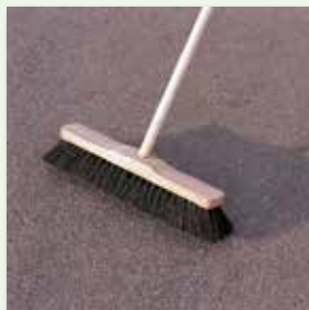
Untergrund sorgfältig vorbereiten
