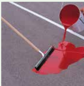
Material vollständig ausgießen und mit Gummischieber verteilen
