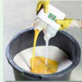
Bindemittelkomponenten zugeben
