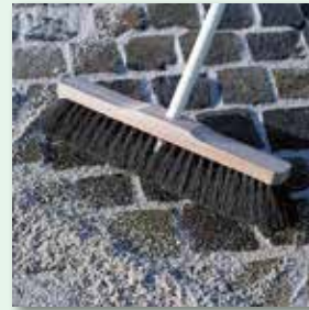
mittels feuchtem Besen abfegen
