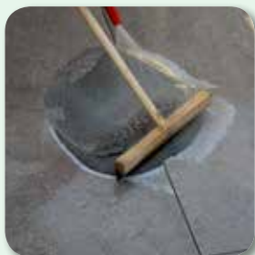
Etaler le mortier
