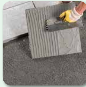
bei Platten unterseitig HaftBrücke auftragen
