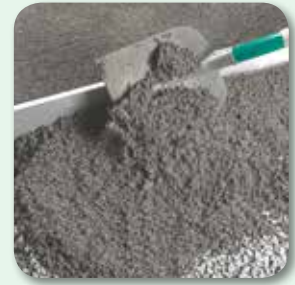
Mörtel aufbringen und über Lehren abziehen
