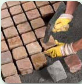
Pflaster hammerfest setzen
