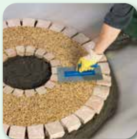
verdichten und glätten
