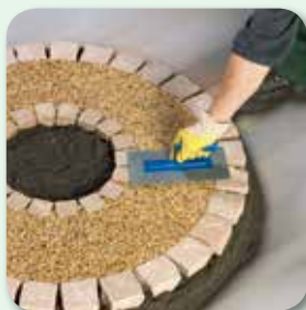
verdichten und glätten
