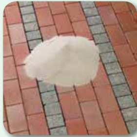
Fugen mit Quarzsand ...
