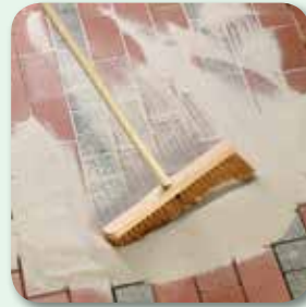
... vollständig füllen
