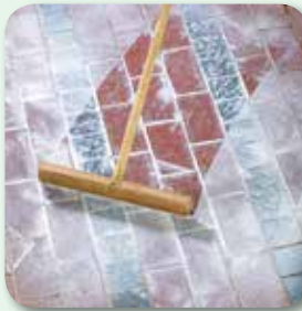
Überschuss entfernen
