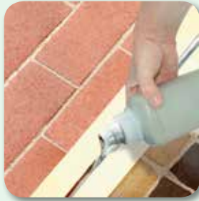
in die Fugen gießen
