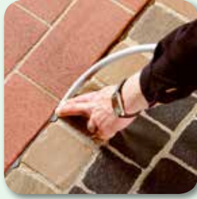
Fugentiefe mit PE-Rundschnur fixieren
