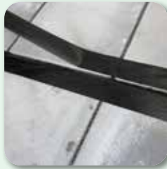
Fugenraum säubern und Kanten abkleben
