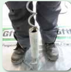
Komponenten in der Kartusche im Gebindehalter mischen
