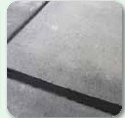
Vor der Aushärtung Klebebänder entfernen
