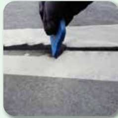
Abziehen, Klebebänder entfernen und Fugenoberfläche glätten
