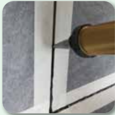
Fugenverschluß bei senkrechten und waagerechten sowie Eckfugen
