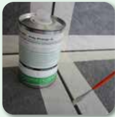
Fugenraum säubern und Fugenflanken primern
