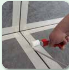
Fugenfüllprofil \geq 10 mm eindrücken
