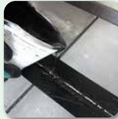
vdw 380 PolyfugenFlex in die Fuge gießen
