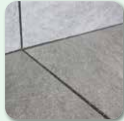
Nach vollständiger Erhärtung überschüssigen Sand entfernen.
