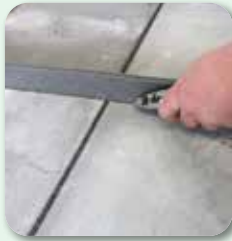
Dehnungsfugenband \geq 10 mm tief freischneiden
