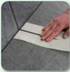
Oberfläche säubern und Kanten abkleben
