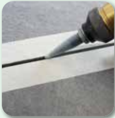
Kanüle passend kürzen und vdw 385 in die Fugen verpressen
