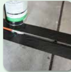
Fugenflanken mit Primer grundieren
