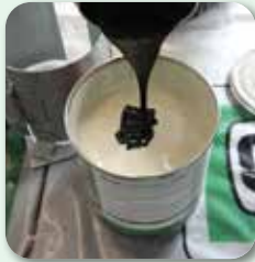
B-Komponente in die A-Komponente entleeren
