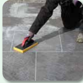
Fugen glätten und Oberfläche rückstandsfrei abwaschen
