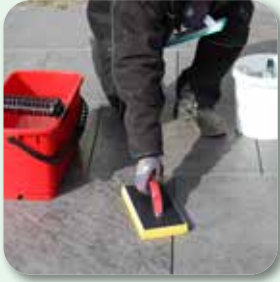
Fläche mittels Schwambrett vornässen
