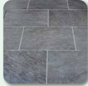
Fertige Oberfläche (ggf. Nachbehandlung beachten)
