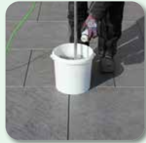
Bindemittelkomponente zugeben und homogen vermischen
